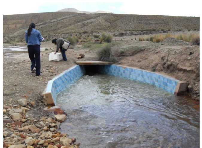
Descarga de aguas Campamento minero Bolívar
